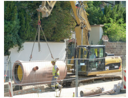
Замена старых керамических трубопроводов новым коллектором диаметром DN1000
