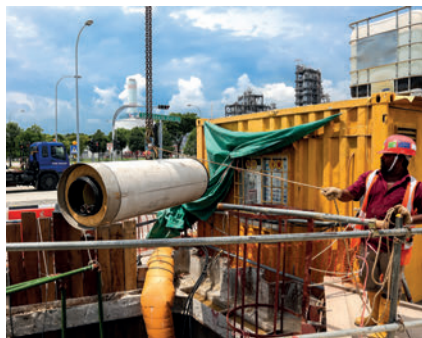
Достоинства бетонных труб – высокая статическая стойкость и прочность – были усилены за счет наращивания толщины стенок до 130 мм
